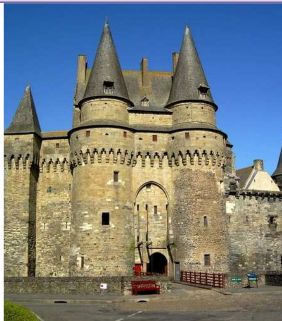
Entrée du château (ancien pont-levis)
